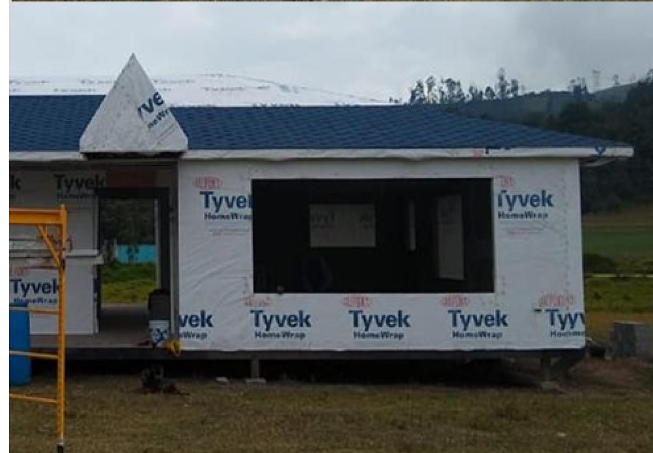
Nota: Una barrera de control del flujo de vapor debe ser completamente hermética y proporcionar un control efectivo de la condensación.
